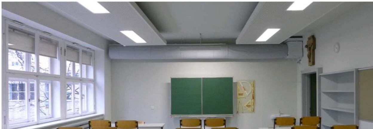
Figura 17 – Silenziatore e prototipo di fanbox prodotto da ATREA – Fonte: “Active overflow ventilation for refurbishing of school buildings” 3ENCULT – Efficient Energy for EU Cultural Heritage
