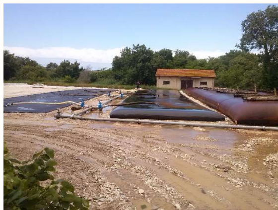
Dewatering: tubolari in geotessile drenante
