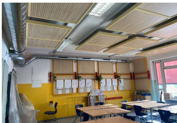
Installazione degli impianti VCM del progetto necessAria. Fonte https://www.necessaria.it/news-eventi/in-dettaglio/avviata-l-installazione-delle-35-vmc-del-progetto-necessaria
