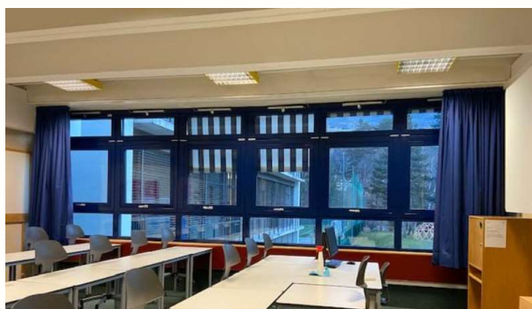
Finestra con apertura automatica in funzione della concentrazione di CO 2
